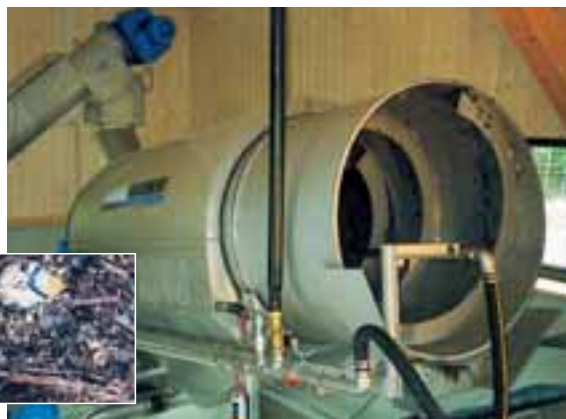
Lavado y separación de los gruesos > 10 mm con tromel de lavado ROTAMAT®
