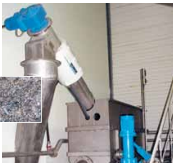
Tamizado a 1 mm y deshidratación del residuo orgánico con tamiz ROTAMAT® (sequedad 30%)
