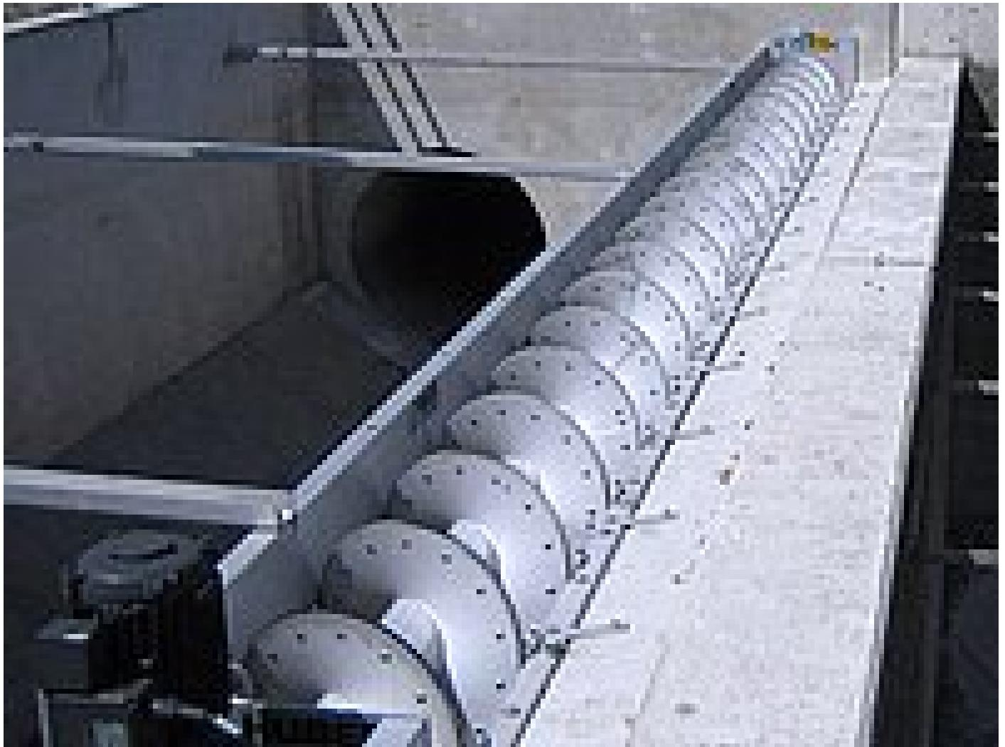
Tamices autolimpiantes para tanques de tormenta con aliviaderos y para colectores con descarga de pluviales
