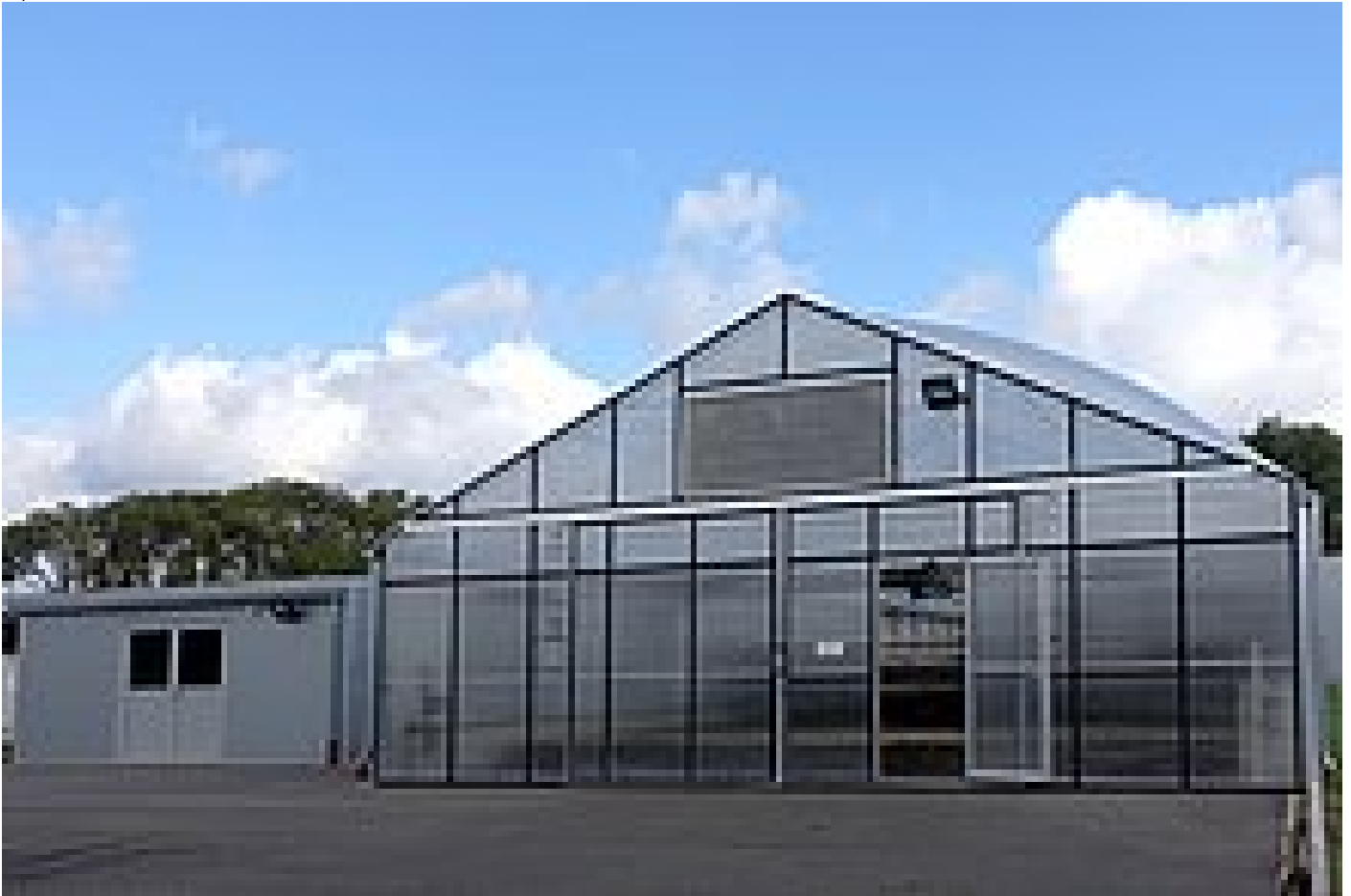
La planta de tratamiento de lodos está totalmente automatizada y requiere un bajo mantenimiento
