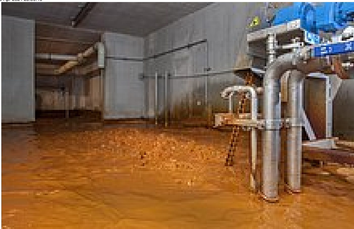
Imagen 4: Biología de membranas, una cámara de filtración con filtración por membrana VRM® 30/18 RF de HUBER
