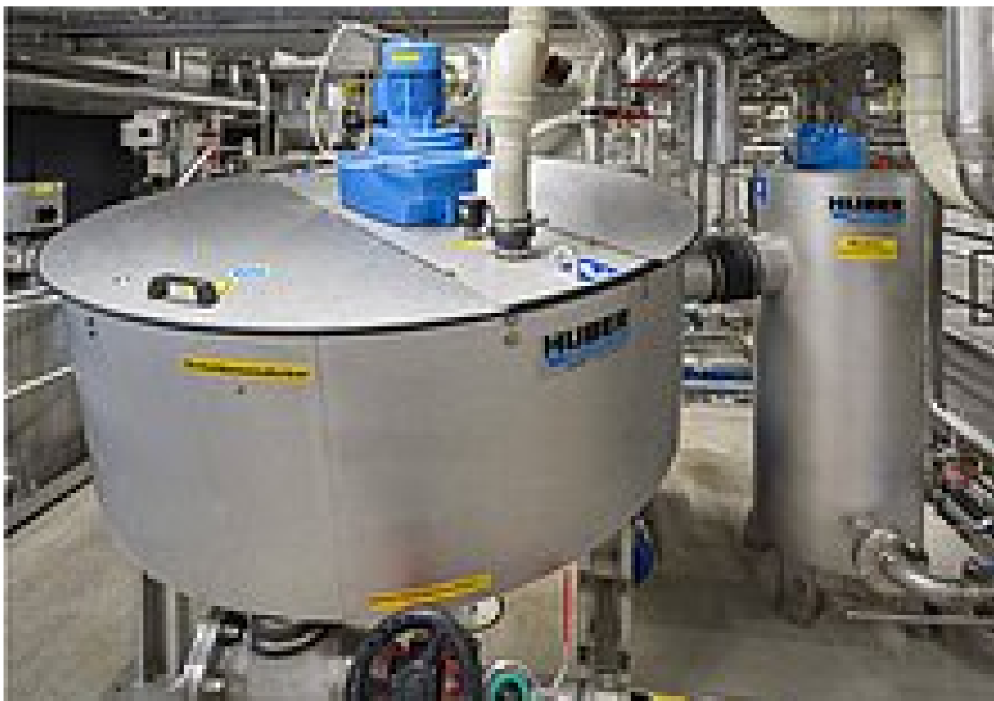
Imagen 5: Espesamiento del lodo flotante y el lodo excedente con el espesador de disco S-DISC de HUBER
